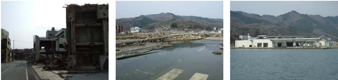
写真：宮城県女川（4月）。左から、津波で建物が横転、市街地は壊滅的、中央は地盤沈下の様子、右は魚市場の状況。
