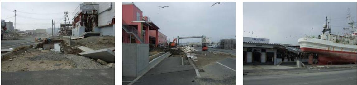
写真：宮城県石巻（4月）水産加工団地が全面的に被災した。この時は冷蔵庫内の在庫の処分を行っていた。地盤沈下も顕著にみられ、復旧の大きな障害となると考えられる。
